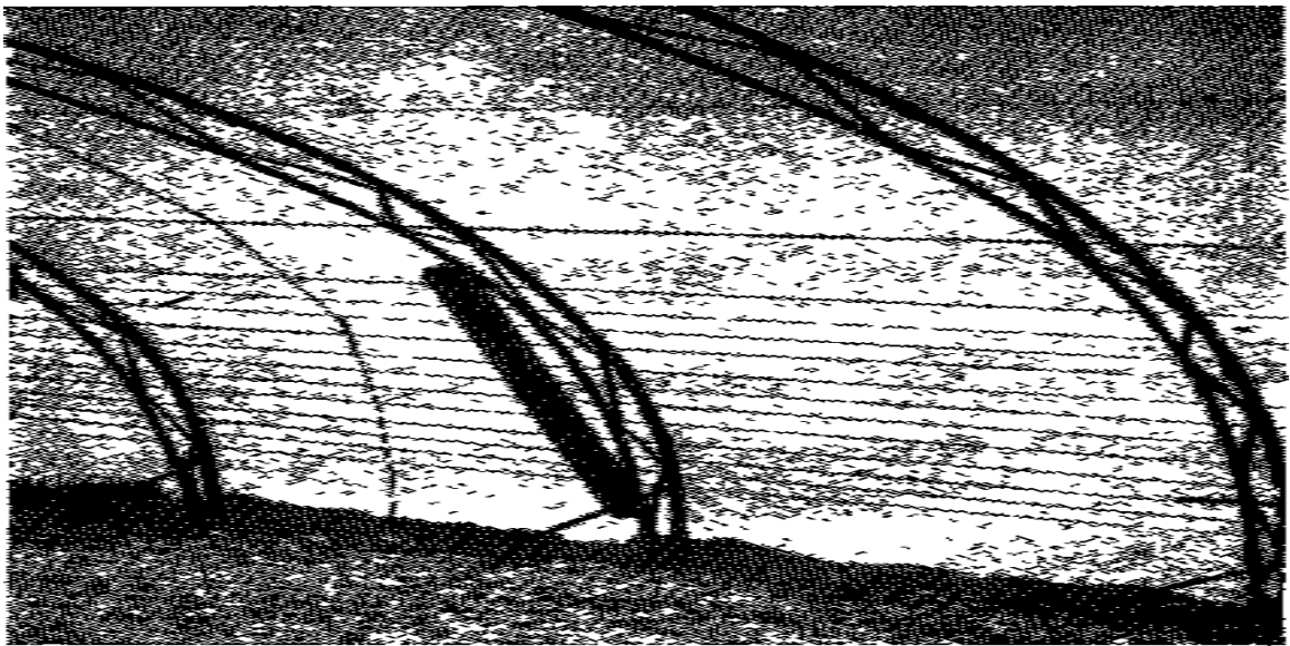
Рис.9. Обогрев пленочной теплицы проводом ПОСХВ.
